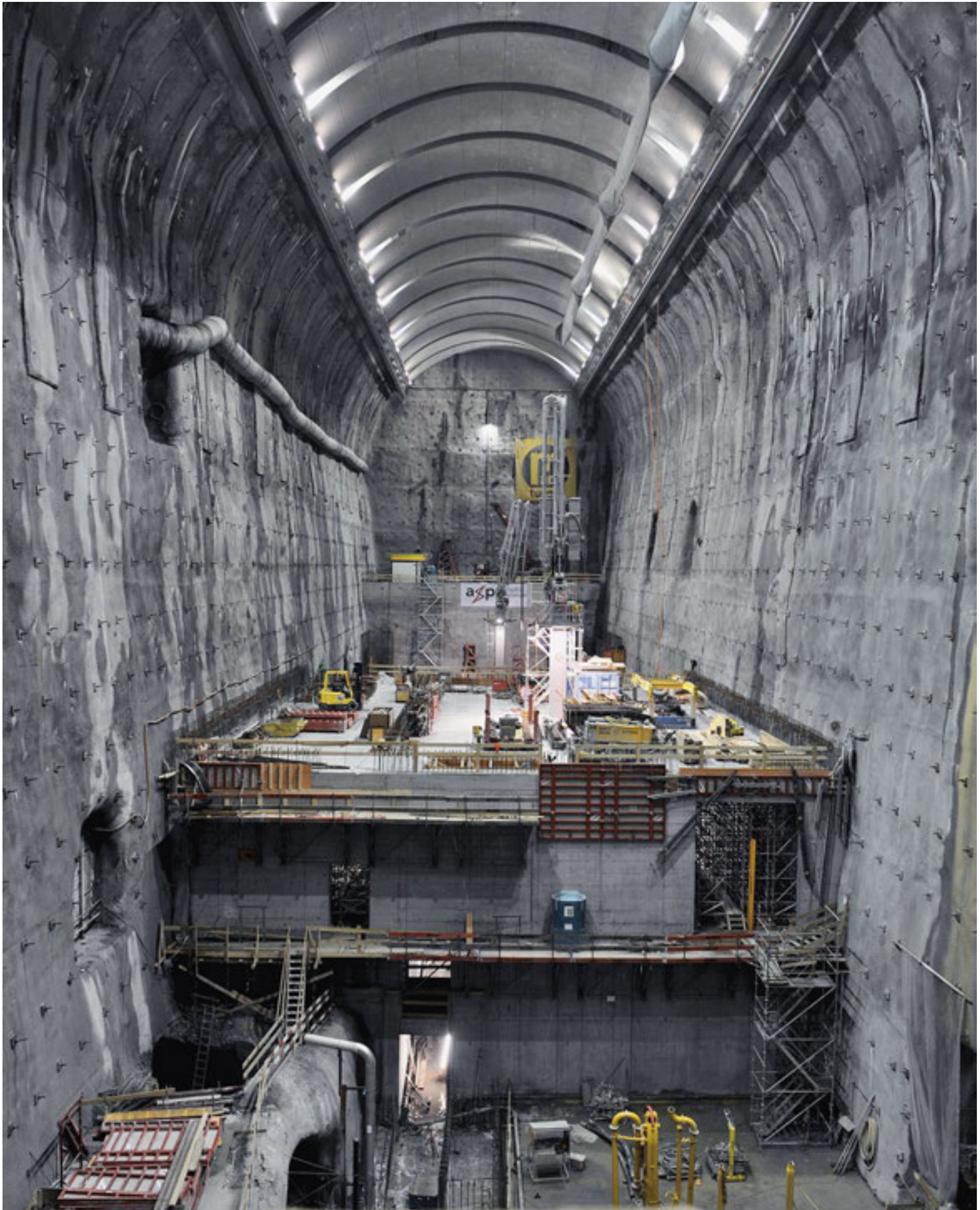
1_Rohausbau der ausgebrochenen Maschinenkaverne. Gros œuvre du creusement de la caverne des machines. Costruzione grezza della grotta dei macchinari.
