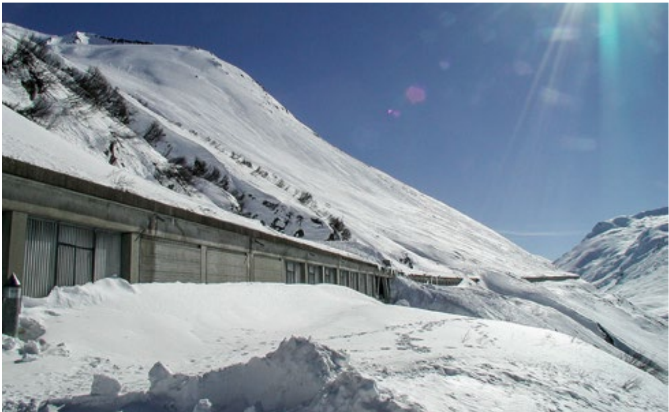
Lawinengalerie Scopi im Winter. Die Lukmanierstrasse wird nördlich der Passhöhe durch viele Lawinenzüge gefährdet. Zum Schutz des Verkehrs wurde in den 1960er-Jahren die etwa 2 km lange Lawinengalerie Scopi gebaut. Im Winter ist die Galerie zum Teil beinahe vollständig mit Schnee von Lawinniedergängen eingedeckt.
